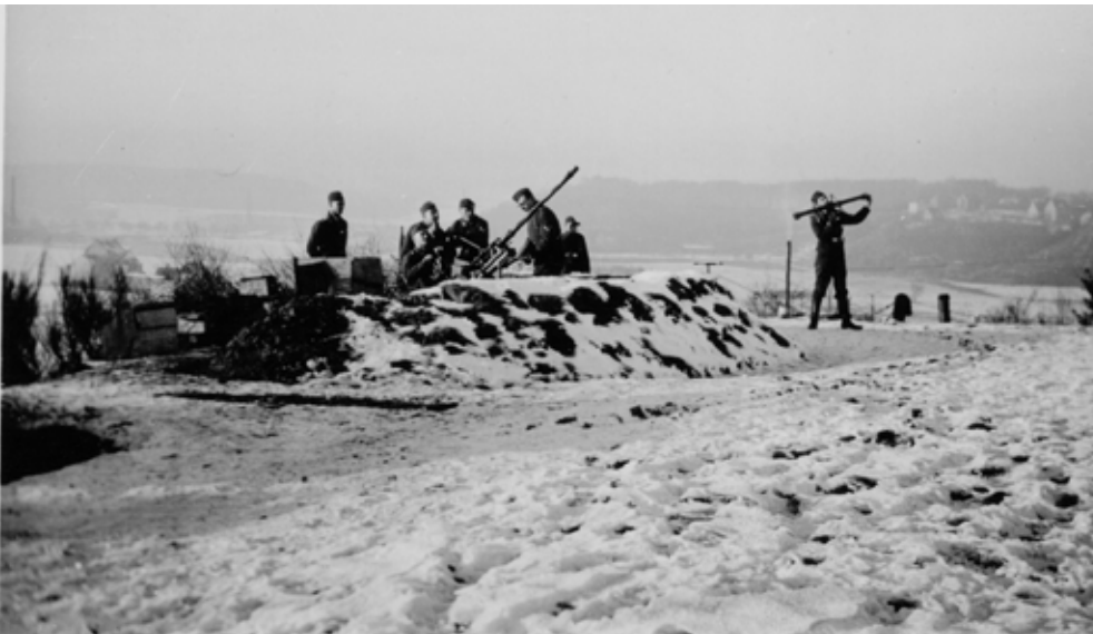
Posieren mit der Panzerfaust im Anschlag: ein heute eher befremdlicher Anblick. Im Hintergrund der Schlot des Ringofens Sassen an der Bergischen Landstraße
